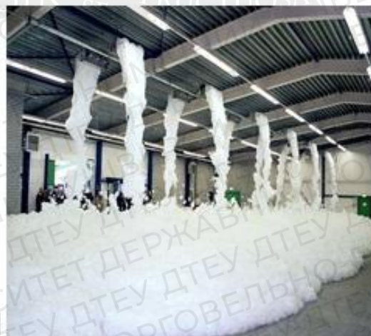
Рис. 2.6. Схема піноутворюючої системи пожежогасіння в приміщенні АТ «КБ «Глобус»
